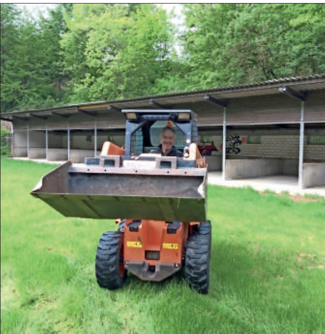
Es tut sich etwas auf der „Baustelle Generationenpark“: Jost Kimmel, neugewähltes FVM Vorstandsmitglied im Einsatz. Foto: privat
